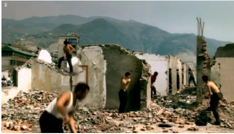
Görsel 45: Yıkım için çalışan işçiler
