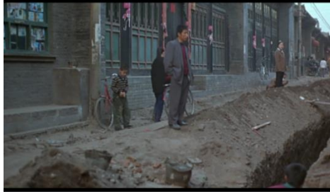
Görsel 43: Sokakta yol çalışması (Platform)
