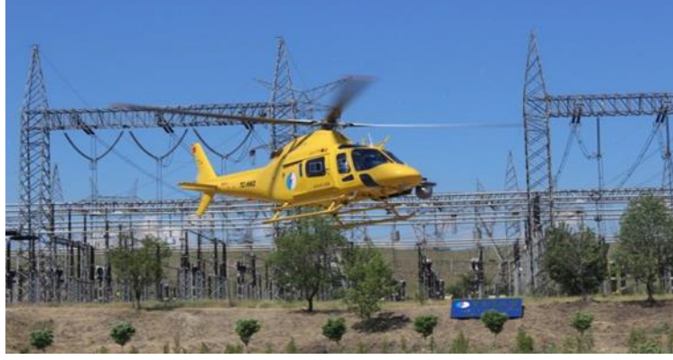
Şekil 2.1. Enerji iletim hatlarında kullanılan helikopter [8]
