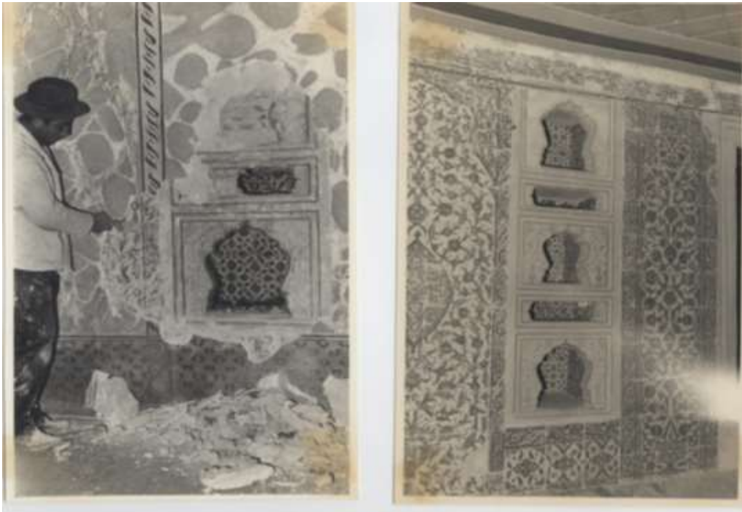
EK B.7: Valide Sofası'nın çeşitli devirlerde sıva ile örtülmüş mermer nişleri, 1968-69 onarımları (Encümen Arşivi)
