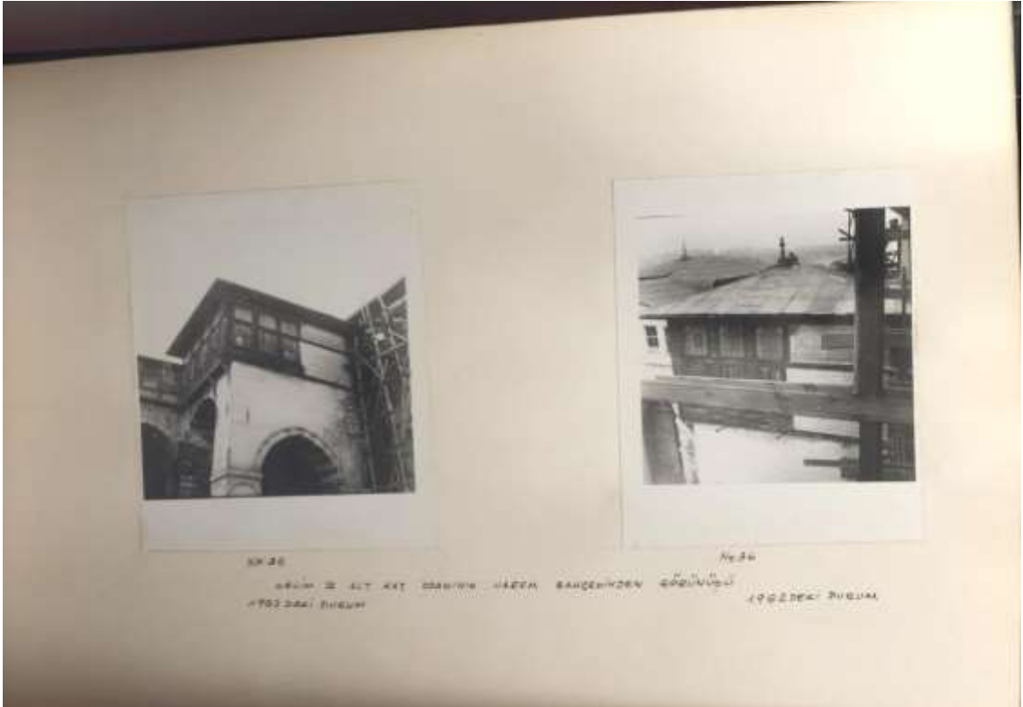
EK B.11: III. Selim Alt Kat Odasının Harem Bahçesinde Görünüşü (Encümen Arşivi, Haz: Selma Emler)
