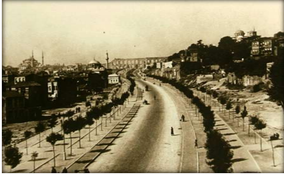
Resim 34: Atatürk Bulvarı tamamlanmak üzere (1945)
