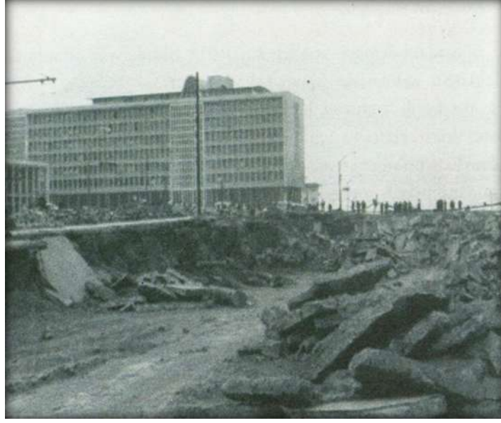
Resim 76: Haşim İşcan Geçidi'nin yapım çalışmaları
