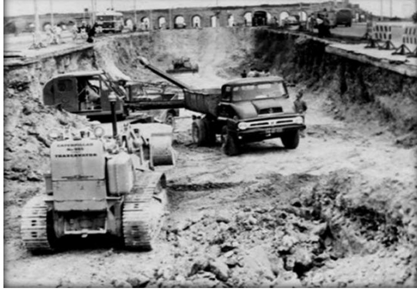
Resim 29: Atatürk Bulvarı ikinci etap çalışmaları sırasında.
